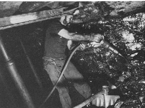
Abattage au marteau piqueur en tête de taille où l'accès du rabot est impossible.
