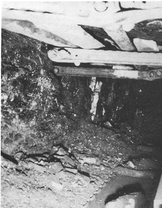
Une vue de la taille avec le nouveau mode de soutènement avec des rallonges placées au ras du front de taille.
