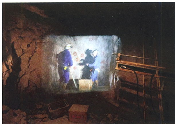
Photo 9. Minage dans un chantier souterrain. Crédit-Photo : Pierre-Christian Guiollard.
