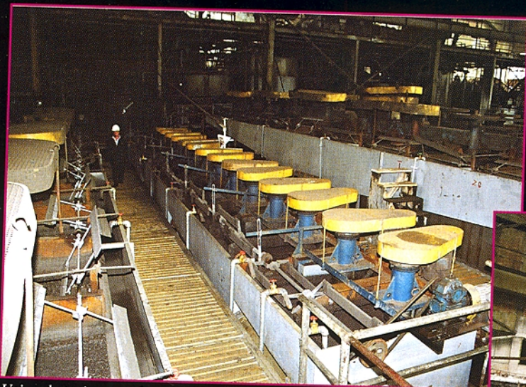
Usine de traitement des minerais de Tuneli Pare, les cellules de flottation. Photo : PCG
