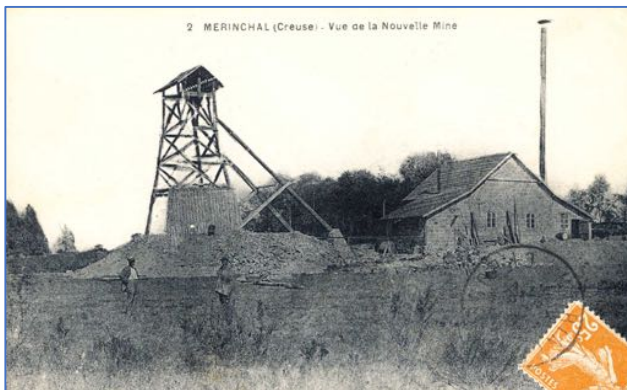
Le nouveau puits de Lapeyrouse en cours de fonçage. Carte postale ancienne – Col. P.C. Guiollard
