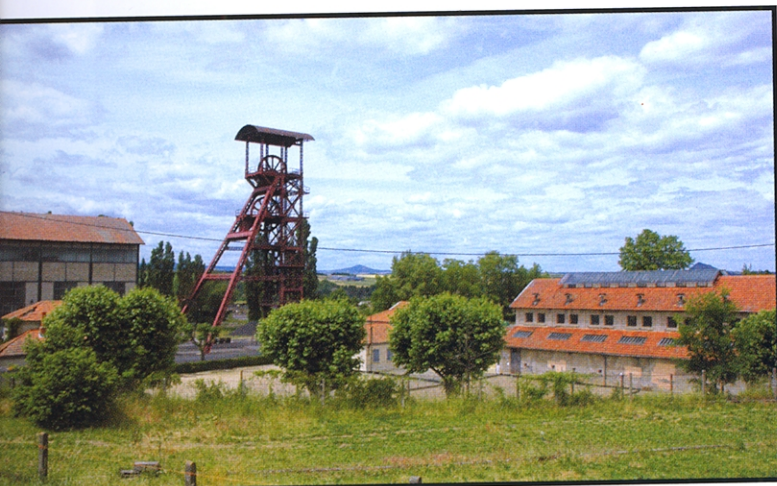
Chevalement du puits Bayard et les bâtiments annexes conservés dans le cadre du musée de la mine à Brassac-les-Mines (Puy-de-Dôme). 2014. Photo P.C. Guiollard
