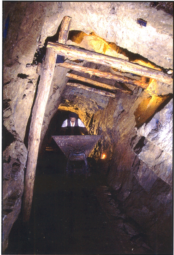
Mine de manganèse de Coustou à Vielle-Aure (Hautes-Pyrénées). Roulage du minerai dans un travers-banc. 2004. Photo P.C. Guiollard
