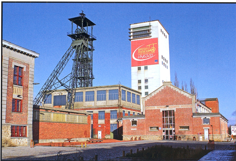
Fosse 11/19 des mines de Lens. Ancien site minier comprenant notamment un chevalement métallique des années 1920 et une tour d'extraction moderne datant de 1960. Les installations ont été réaménagées afin d'accueillir des entreprises et des associations. Exemple de conservation du patrimoine minier par la reconversion. 2010. Photo P.C. Guiollard
