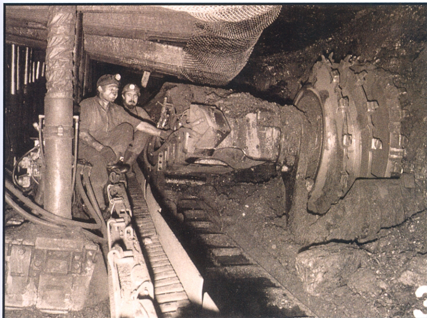
Blanzy, haveuse en taille, siège de Rozelay, 1980. Fonds doc. Houillères Centre-Midi
