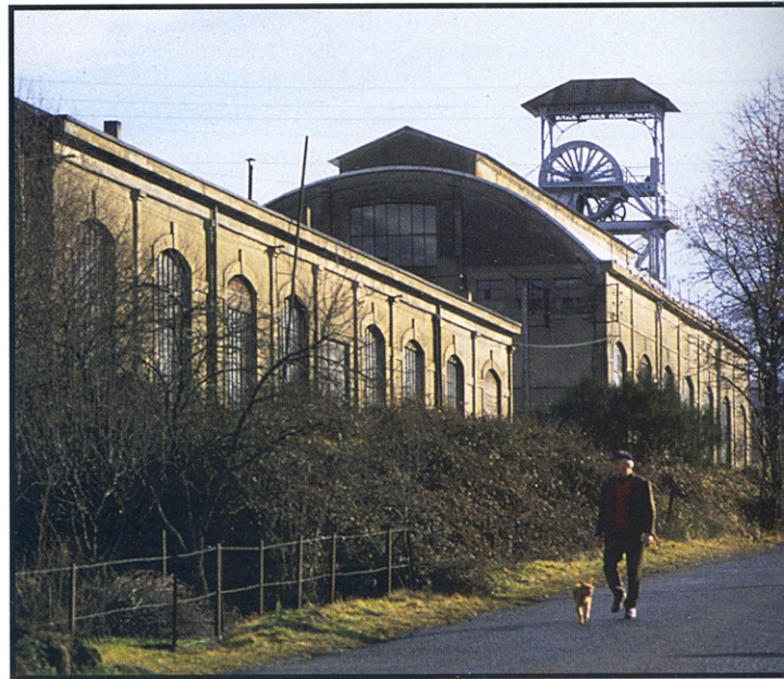
Houillères d'Auvergne, le puits Saint-Louis à Messeix (Puy-de-Dôme). 1986. Photo P.C. Guiollard
