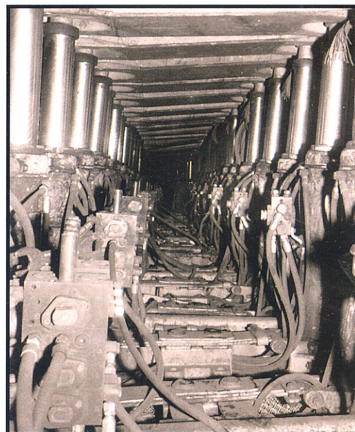
Soutènement marchant. Siège de Darcy, 1980. Fonds doc. Houillères Centre-Midi
