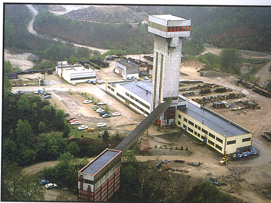
Cogema Margnac Puits P5 de Margnac, le plus important siège minier de COGEMA en Haute-Vienne. 1988. Fonds doc. COGEMA / AREVA Mines
