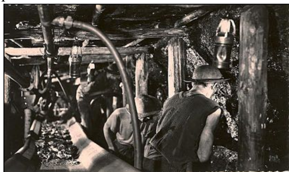
Fig 11 – Une taille dans les années 1920, abattage au marteau piqueur.
