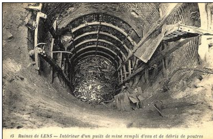
Fig 3 – Les puits sont noyés.
