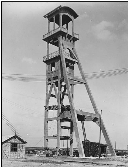
Fig 10 – Chevalement de puits de service en béton armé
