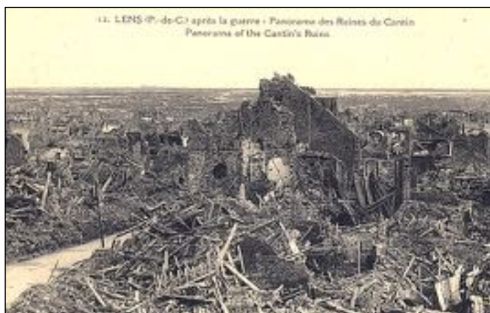
Fig 4 – Les habitations sont détruites.
