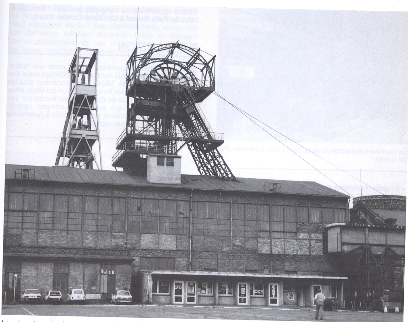
Les chevalements des puits Simon nos 1 et 2 à Forbach (Moselle).
