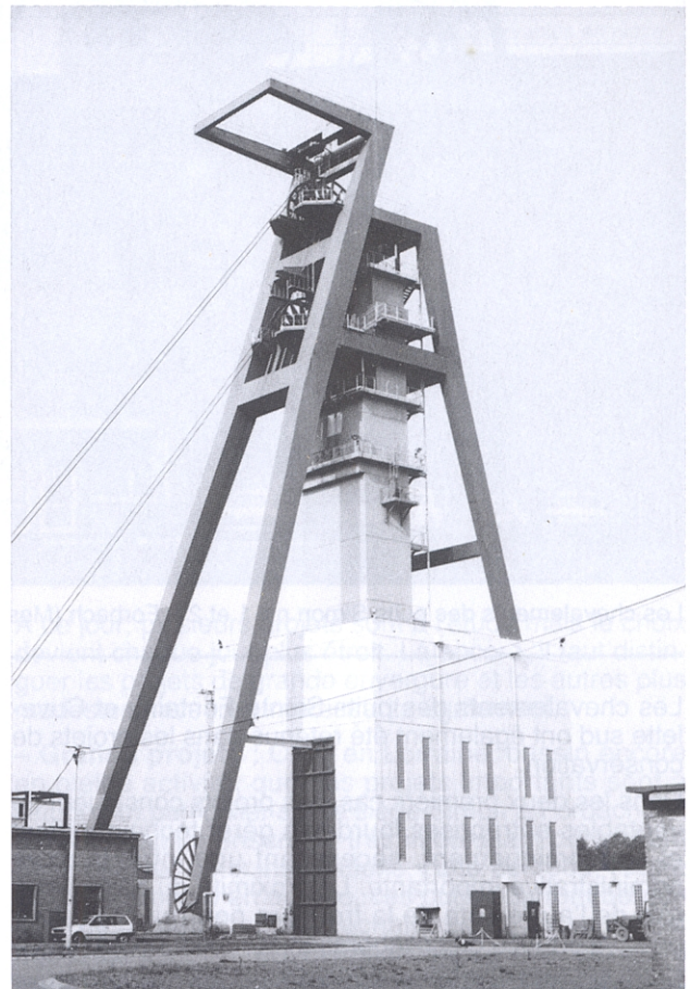
Le chevalement du puits de Vernejoul aux Houillères de Lorraine.
