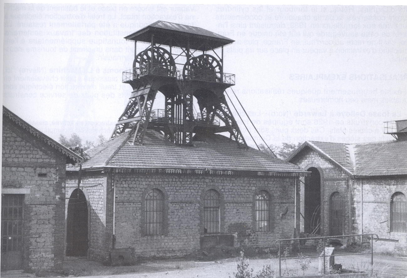
Les installations de surface du puits du Marais au Chambon-Feugerolles (Loire) en 1985, avant démolition des bâtiments.
